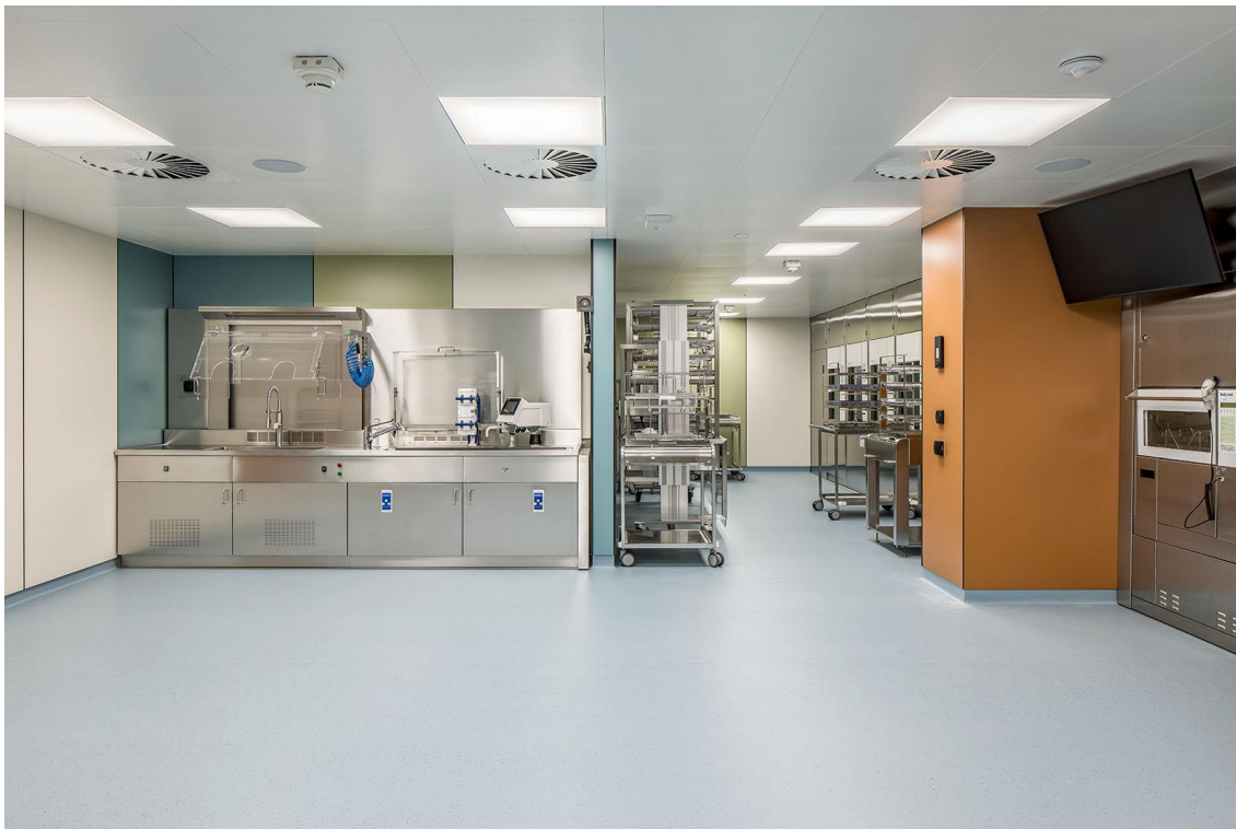
Abbildung 4: Neu sanierte AEMP
